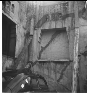
Murs fendus, écaillés et lépreux, étais placés en 1958
