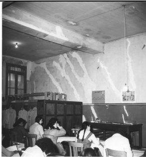
Poutre fléchie et fissurée, mur fissuré.
