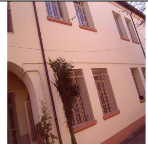
Ecole « Ibn Marzouk » en 2010 après réfection
