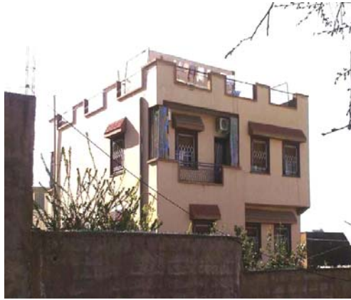
Fig. 3: Vue de l'habitation (coté Est)
