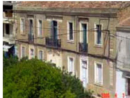
Fig. 2: Façade Sud-ouest (entrée, côté rue) (Source: Auteur)
