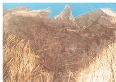
Figure 09 : dégâts sur le cœur du
